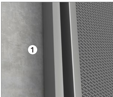
HAT-profiler skruvas direkt i väggen.
