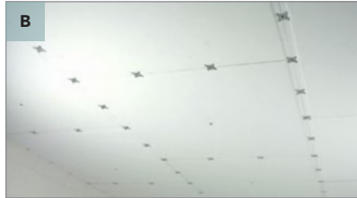
Montaż panelu: Panele Rockfon Mono Acoustic należy przymocować mechanicznie do konstrukcji. Możliwy jest również montaż bezpośredni (mechaniczny/klej) do szczelnego podłoża.
