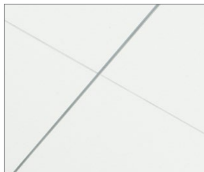
Utworzenie ostrej i równej linii dzięki cofnięciu konstrukcji nośnej w jednym kierunku wzdłużnym oraz gładkim łączeniom w drugim kierunku wzdłużnym.
