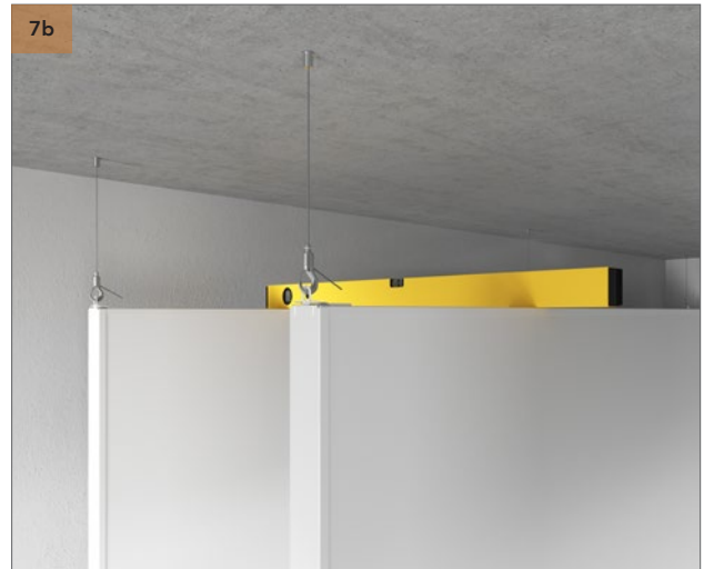
7b Plasser et vater på toppen eller under baflene for å sikre at de henger jevnt og er i vater i alle retninger. Nivellering gjøres ved å løsne wirelåsen på kroken og justere med wiren.
