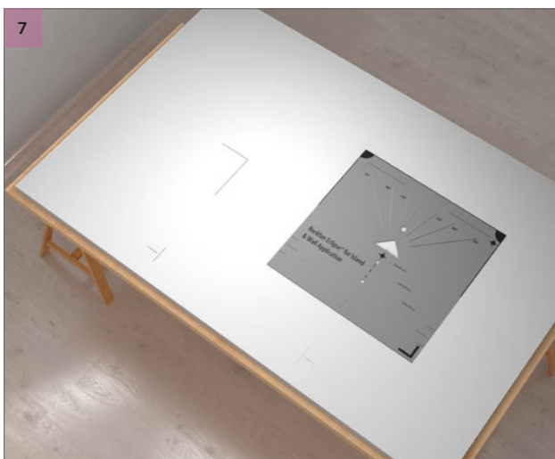
Marker linjene hvor opphengsbleslaget skal monteres. Gjør dette for både høyre og venstre side av veggabsorbenten. Se detaljer på bilde 7.
