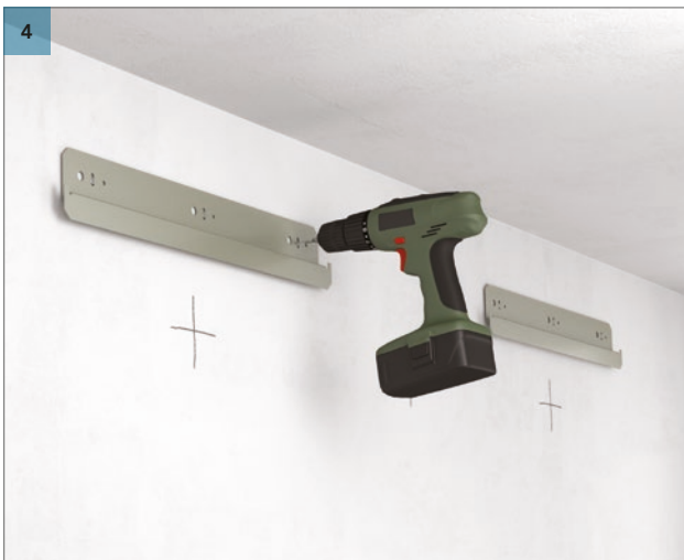
Bor hullene og installer veggbeslaget.
