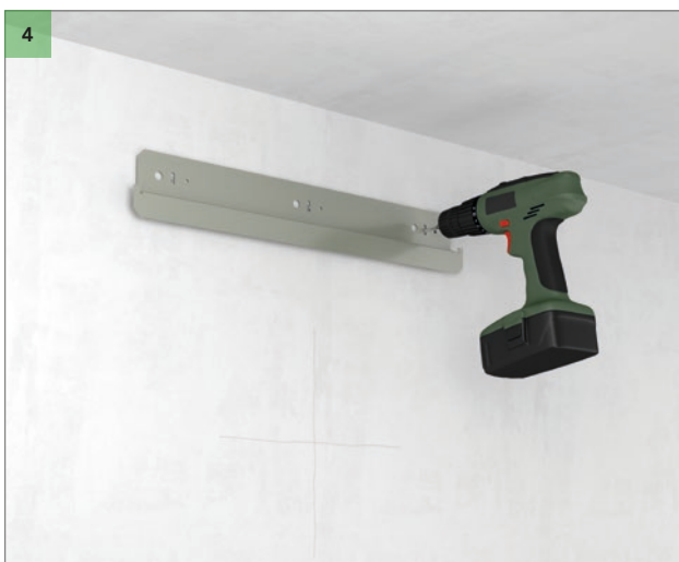
Bor hullene og installer veggbeslaget.
