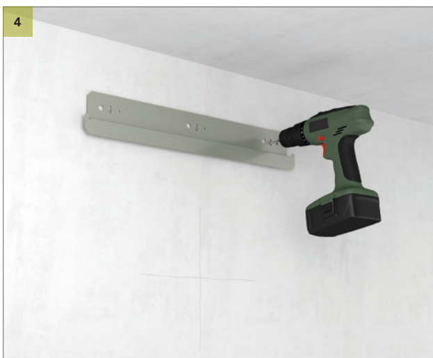
Bor hullene og installer veggbeslaget.
