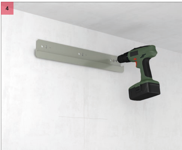
Bor hullene og installer veggbeslaget.
