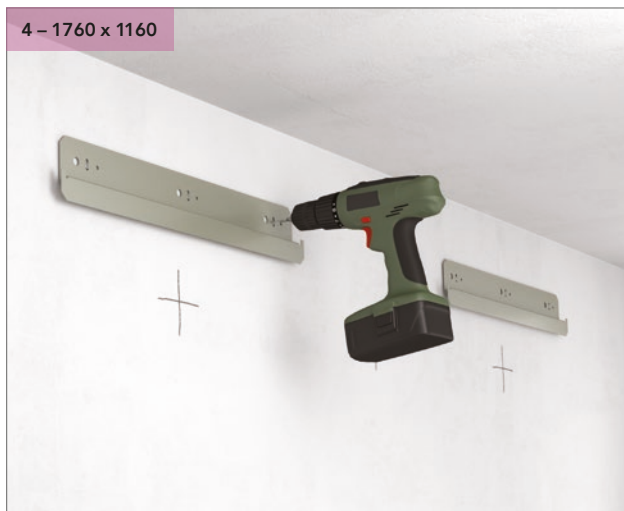
Bor hullene og installer veggbeslagene.
