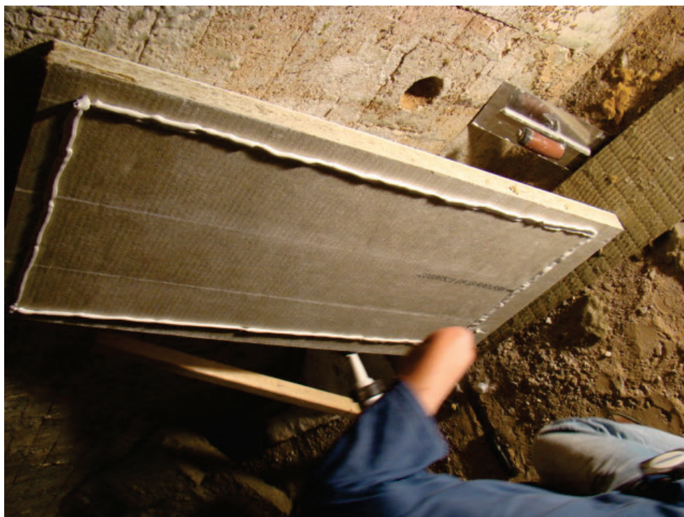
Figuur 1: verlijming van de 50 mm platen
