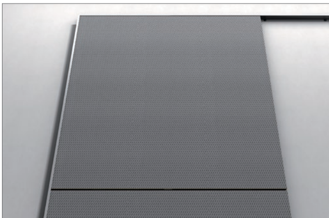
3.5 Installeer de tussenpanelen en werk van boven naar beneden. Houd ze stevig op hun plaats met steunbeugel(s) en randprofiel(en) - zie schema op pagina 6.
