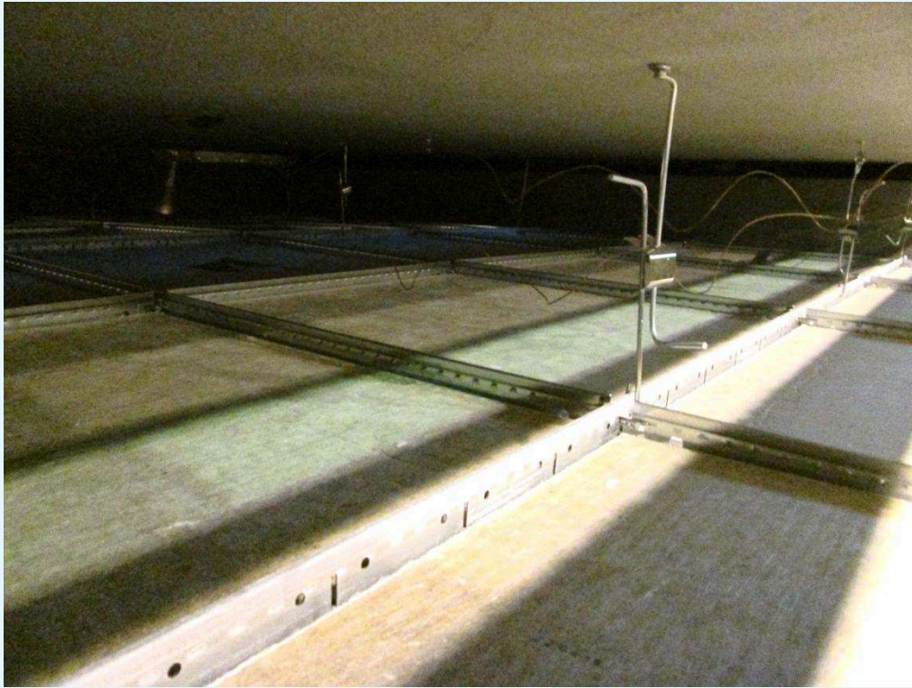
Fotografia dell'intercapedine tra controsoffitto e solaio prima della prova.
