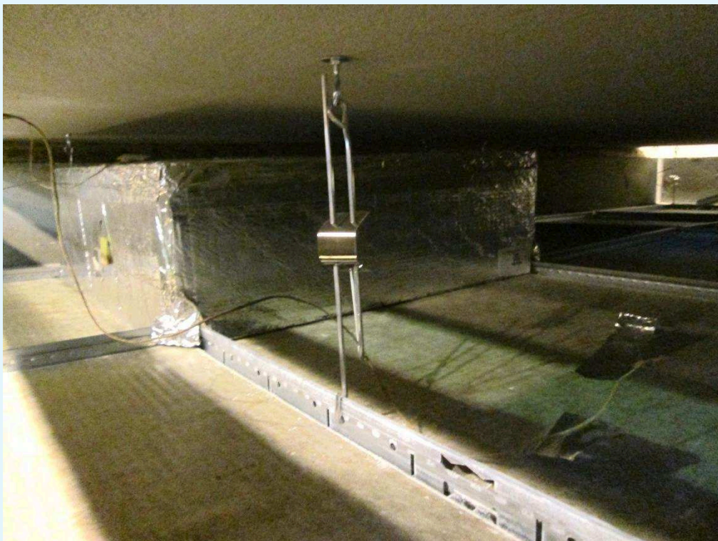
Fotografia dell'intercapedine tra controsoffitto e solaio, zona plafoniera, prima della prova.
