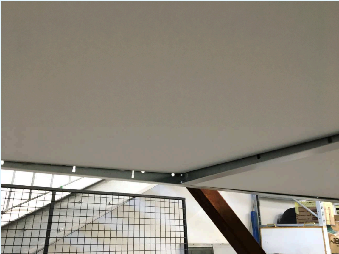
Particolare della parte inferiore del campione al termine della prova.
