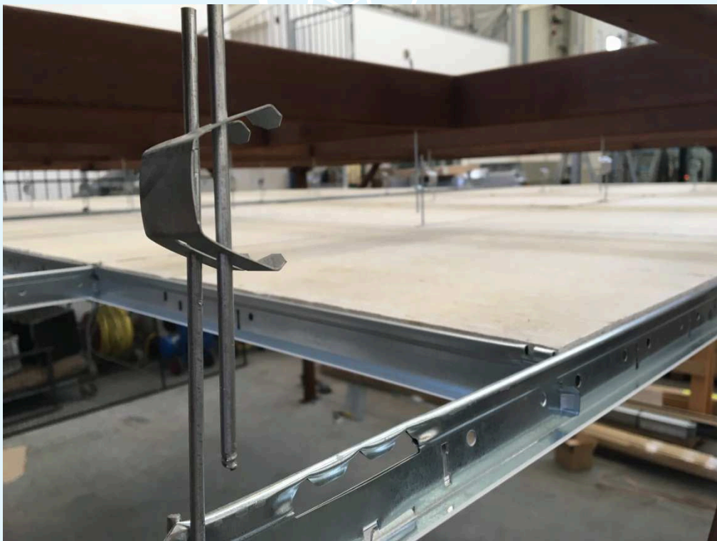
Fotografie della struttura metallica di sostegno e del campione durante l'allestimento della prova.
