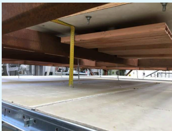
Fotografia dell'allineamento del sistema di carico all'area d'impatto.
