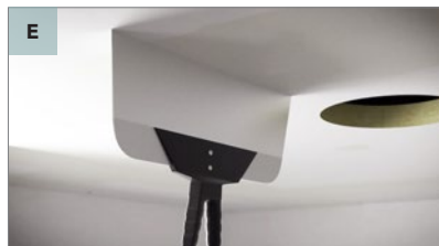
E Controllare i giunti e il centro dei pannelli.
