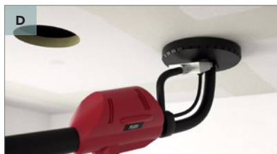
D Carteggiare i giunti: Carteggiare i giunti per livellare la superficie del pannello.
