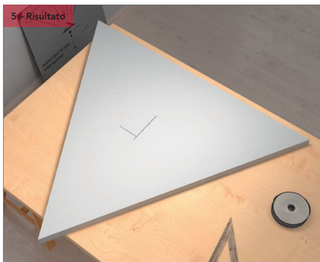
Posiziona la dima nell'angolo inferiore della parte posteriore del pannello murale Rockfon Eclipse. Con una matita traccia le linee centrali, grazie all'angolo della dima. Vedi immagine 5 "Risultato".
