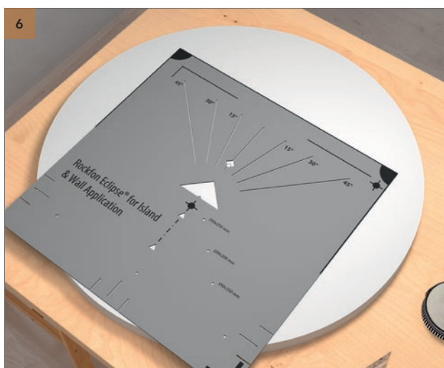
6 Posiziona la dima in modo che le linee disegnate nel passaggio 5 siano perfettamente allineate con il centro del taglio a forma di rombo all'interno della dima. Vedi immagine 6 "Dettaglio".
