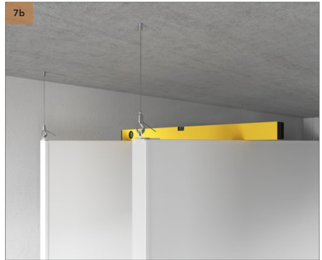
Placer un niveau au dessus ou au dessous du baffle afin de vérifier leur planéité. Il est possible de les mettre à niveau en relâchant le verrou du crochet et en tirant sur le câble.
