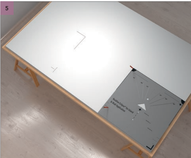
Placer le gabarit de pose dans le coin inférieur droit au dos du panneau mural Rockfon Eclipse. Tracer les lignes formant le centre en utilisant le coin supérieur droit de l'outil et marquer la position de l'écarteur.
