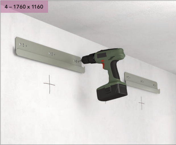
Percer les trous et installer les profilés de fixation murale.
