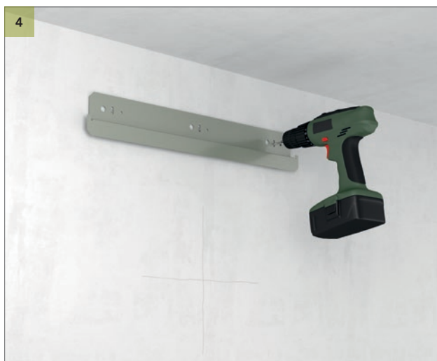
Percer les trous et installer le profilé de fixation murale.
