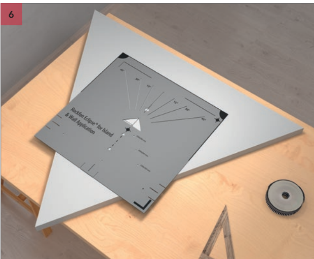
Placer le gabarit de pose de manière à ce que le point à la base du triangle corresponde parfaitement aux lignes de l'étape 5 qui forment le centre. Voir 6 - Détail.
