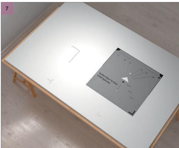
Marquer la ligne où le profilé de fixation pour panneau doit être fixé. Effectuer cette opération sur les parties droite et gauche du panneau mural. Voir 7 - Résultat.
