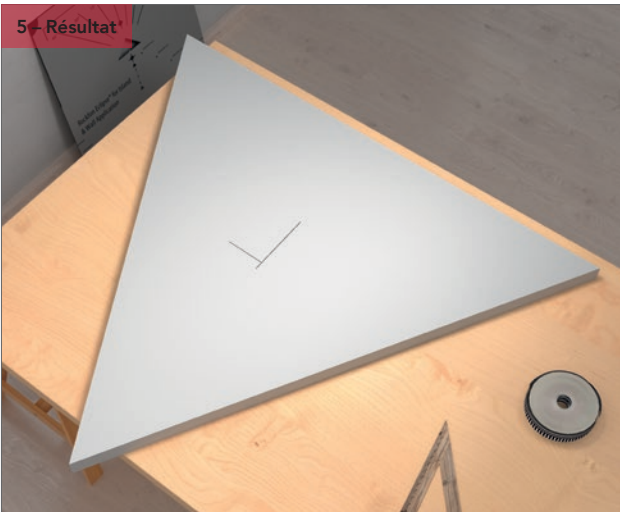
Placer le gabarit de pose au dos et dans le coin inférieur du panneau mural Rockfon Eclipse et marquer les lignes formant le centre du panneau en utilisant le coin de l'outil. Voir 5 - Résultat.
