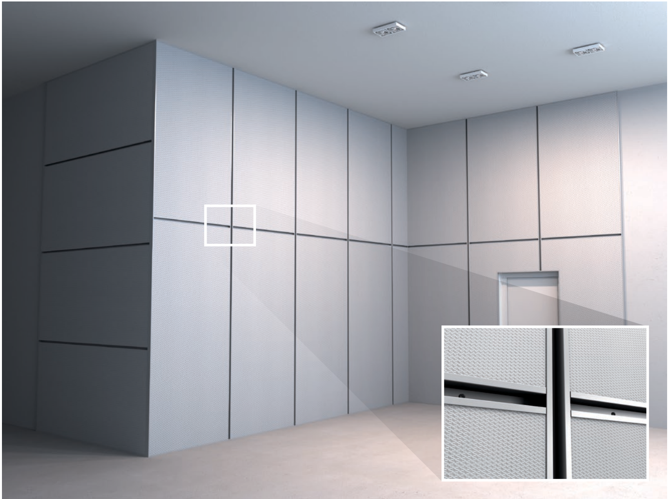
3.1 Kaikki Rockfon VertiQ -seinävaimennuslevyt ja HAT-listat on asennettu.
