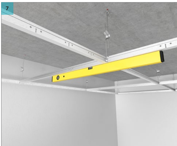
Säädä T24-profiilit vaakasuoraan lankaripustimien jousien avulla. Varmista ennen bafflerien asentamista, että listajärjestelmä on vaakasuorassa.
