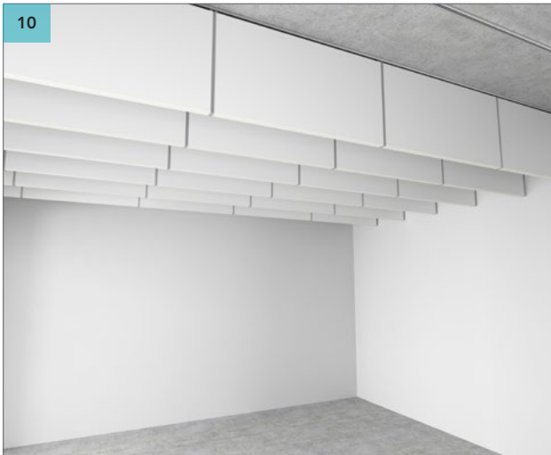
Kiinnitä loput Rockfon Industrial -bafflerit T24-listajärjestelmään. Kohdista ne bafflerien päätyjen kohoumien avulla.
