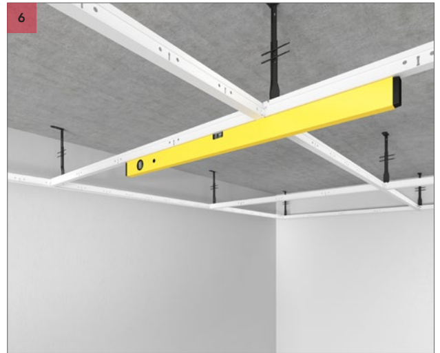
Asenna T24 ECR -välilistat pääkannatuslistoihin 1 200 mm:n välein. Varmista ennen melunvaimentimien asentamista, että listajärjestelmä on vaakasuorassa. Säädä kaikki T24-profiilit vaakasuoraan lukitussokkien avulla.
