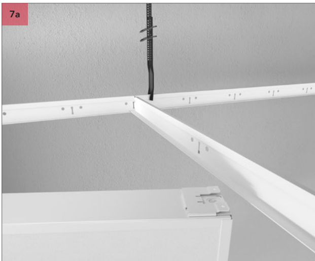
Kiinnitä Rockfon Humitec -Baffleri ripustettuun Chicago Metallic T24 ECR -listajärjestelmään.
