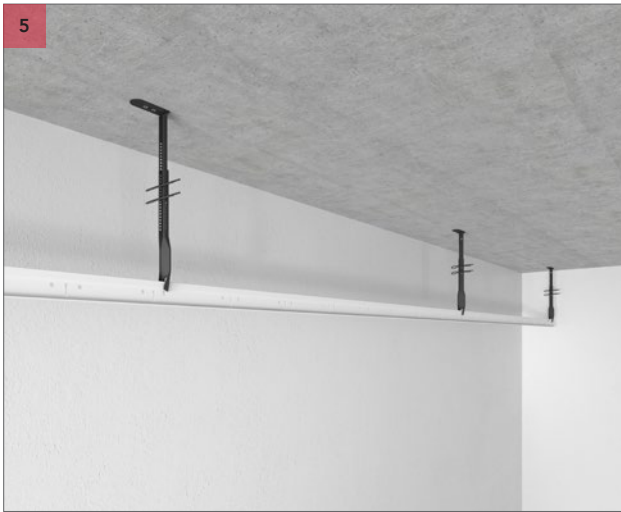
Kiinnitä T24 ECR -pääkannatuslistat Nonius-ripustimien alaosien avulla Nonius-ripustimien yläosiin. Lukitse kahdella lukitussokkalla.
