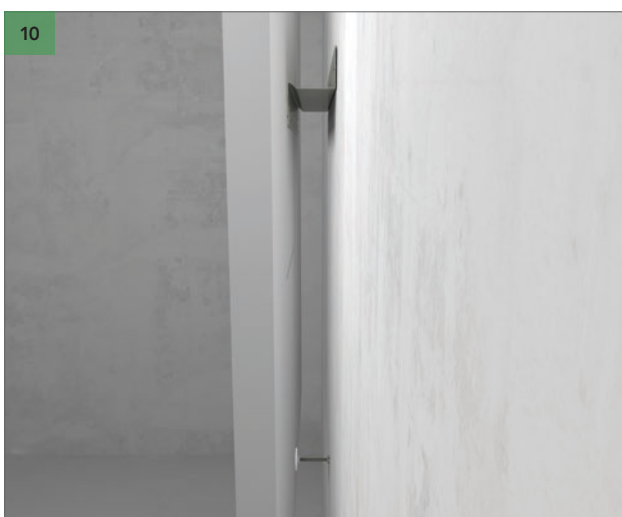
10 Ripusta Rockfon Eclipse -seinävaimennuslevy seinäkiinnikkeeseen. Säädä välikappaletta siten, että Rockfon Eclipse -seinävaimennuslevy on pystysuorassa. Katso lisätietoja kuvasta 10.
