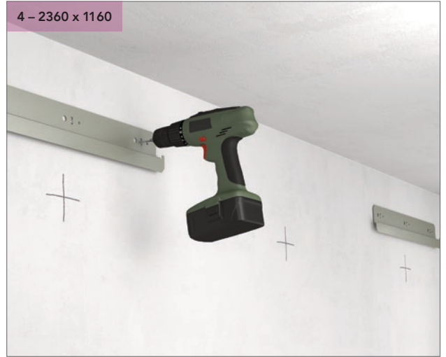
Poraa reiät ja asenna seinäkiinnikkeet.
