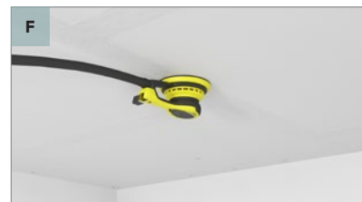
Lijado de juntas: Después de lijar con la herramienta preferida, asegúrese de que las juntas queden perfectamente lisas.
