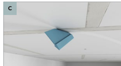
Rellene las juntas, coloque cinta adhesiva y termine las juntas: Rellene las juntas correctamente con la herramienta preferida.
