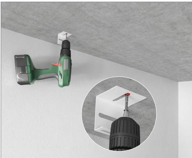
Use las fijaciones apropiadas para el techo. Fije la parte más larga del Soporte de Fijación Directa ECR al techo con fijaciones resistentes a la corrosión de clase D.
