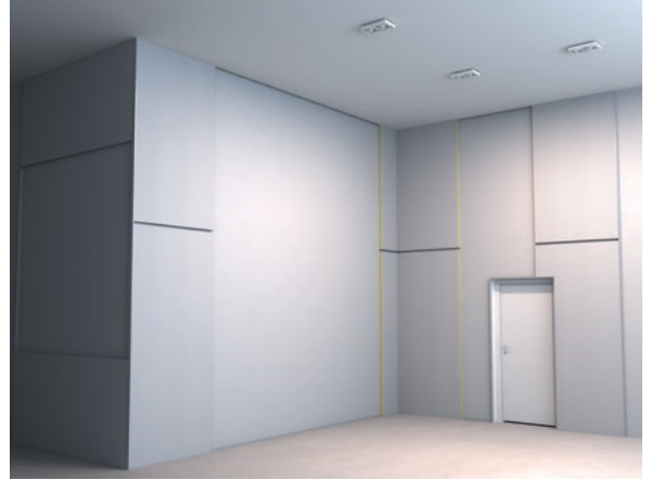
2.3 Alle ydre plader monteret med horisontale profiler.
