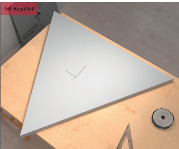
Placér markeringskabelonen i et af hjørnerne på bagsiden af vægabsorbenten og markér centerlinjerne ved at markere langs hjørnet. Se detaljer på næste billede: 5 - Resultat.
