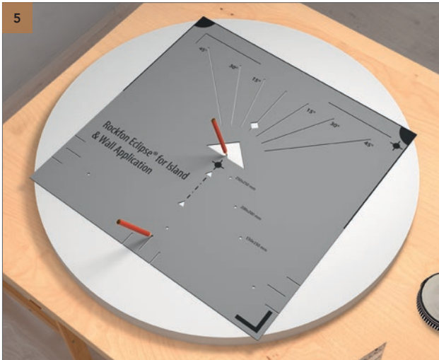
Placér markeringsskabelonen på bagsiden af vægabsorbenten og markér den lille spids i trekantudskæringen og markér placeringen af afstandsbeslaget. Se detaljer på næste billede: 5 - Resultat.
