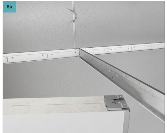
Hängen Sie die Baffel in die Chicago Metallic T24-Unterkonstruktion.
