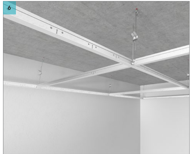
Anschließend werden die 1.200 mm langen T24-Klick-Querschienen mit einem Achsabstand von 1.200 mm montiert.
