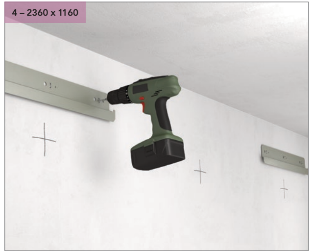
Bohren Sie die Löcher und bringen Sie das Wand-Befestigungsprofil an.
