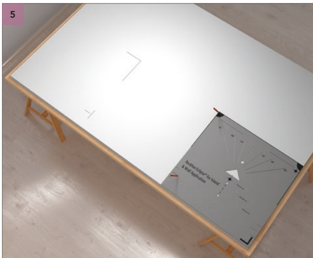
Šablonu umístěte do pravého dolního rohu na zadní straně panelu Rockfon Eclipse Wall. Tužkou vyznačte středové čáry (využijte levý horní roh šablony) a také pozici distančního držáku.
