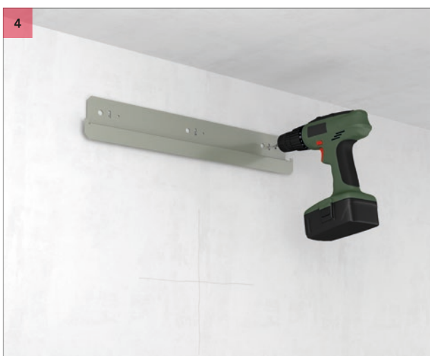
Vyvrtejte otvory a nainstalujte na stěnu fixační stěnový profil.
