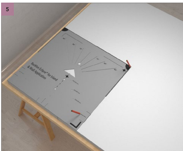
Šablonu umístěte do levého dolního rohu na zadní straně panelu Rockfon Eclipse Wall. Tužkou vyznačte středové čáry (využijte pravý horní roh šablony) a také pozici distančního držáku. Viz obrázek 5 - Výsledek.
