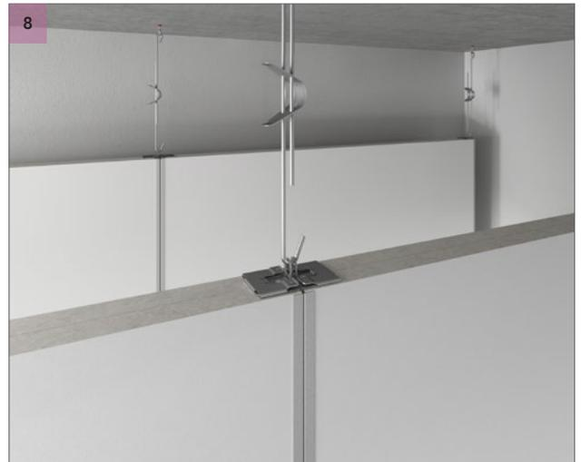
Achten Sie bei der Montage zweier Baffeln direkt nebeneinander darauf, dass die Prägungen in den Endstücken ineinandergreifen und so für eine gute Ausrichtung sorgen.
