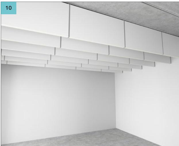
Montieren Sie die restlichen Rockfon Industrial Baffeln und achten Sie darauf, dass die Prägungen in den Endstücken ineinandergreifen und so für eine gute Ausrichtung sorgen.
