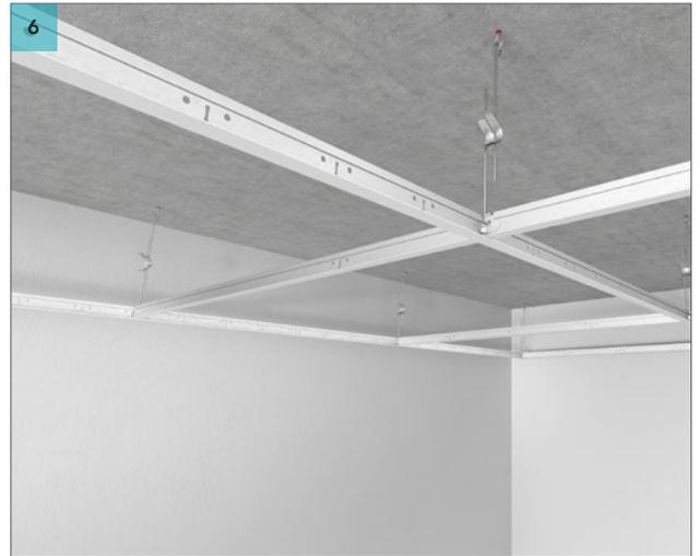
Anschließend werden die 1.200 mm langen T24-Klick-Querschienen mit einem Achsabstand von 1.200 mm montiert.
