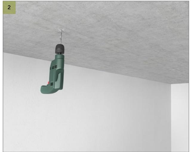
Bohren Sie die Befestigungslöcher für die Führungsschiene. Verwenden Sie für den Untergrund geeignete und zugelassene Befestigungsmittel.
