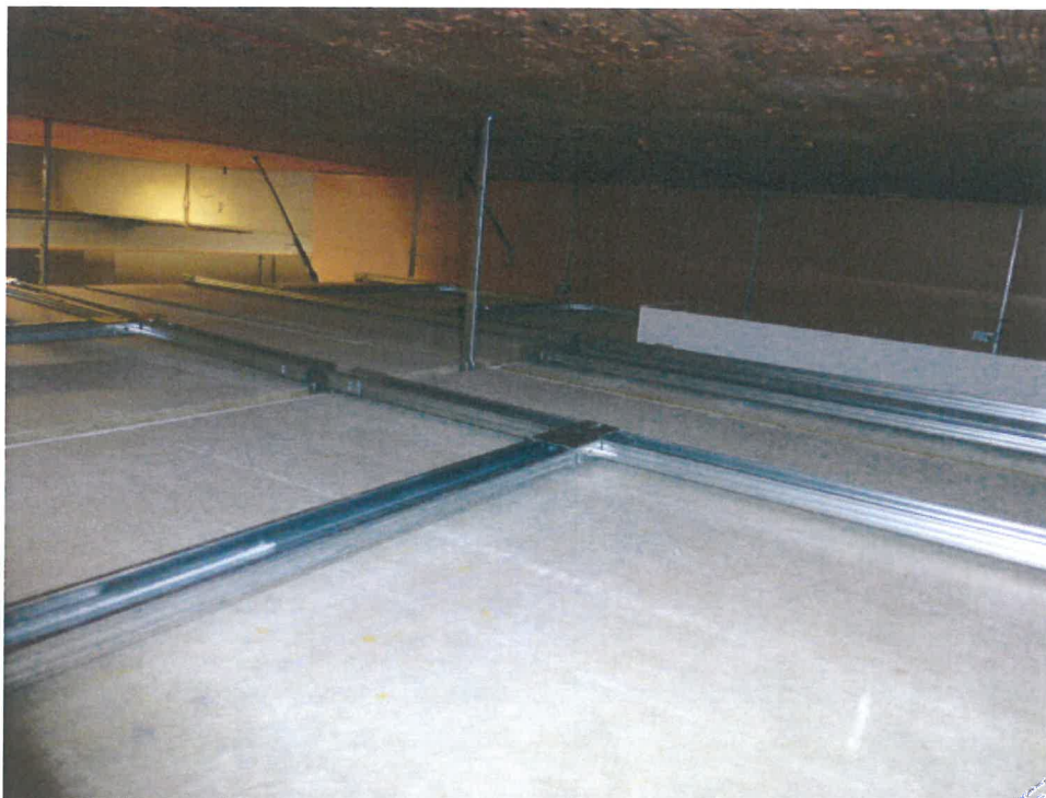
Bild 2 Gesamtansicht: Deckenunterkonstruktion „Olympia Plus“
