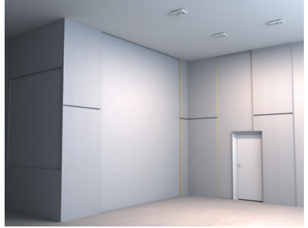
2.3 Alle randpanelen geïnstalleerd met horizontale HAT-profielen.
