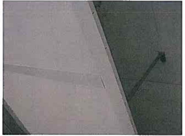
Partie du plafond suspendu (construction support + panneaux de plafond).
