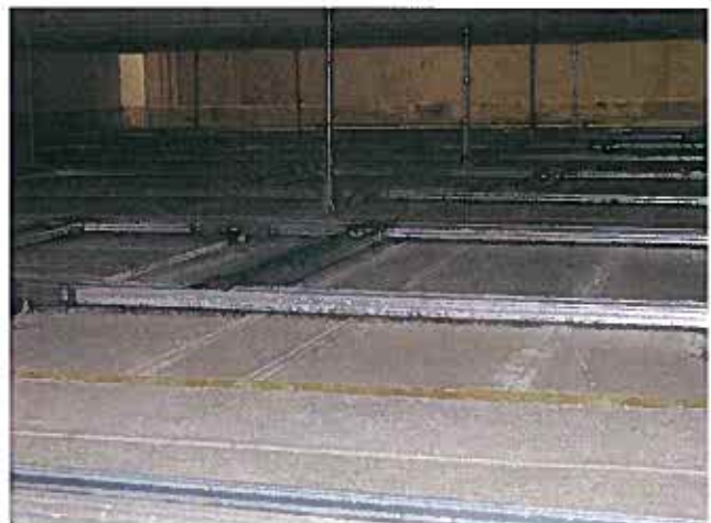
Vue d'en haut du plafond suspendu.
