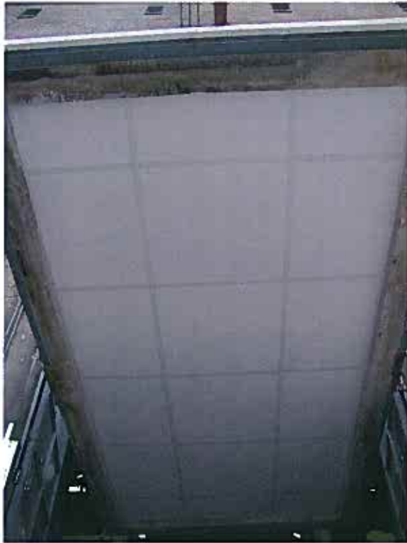
Face exposée avant l'essai.
