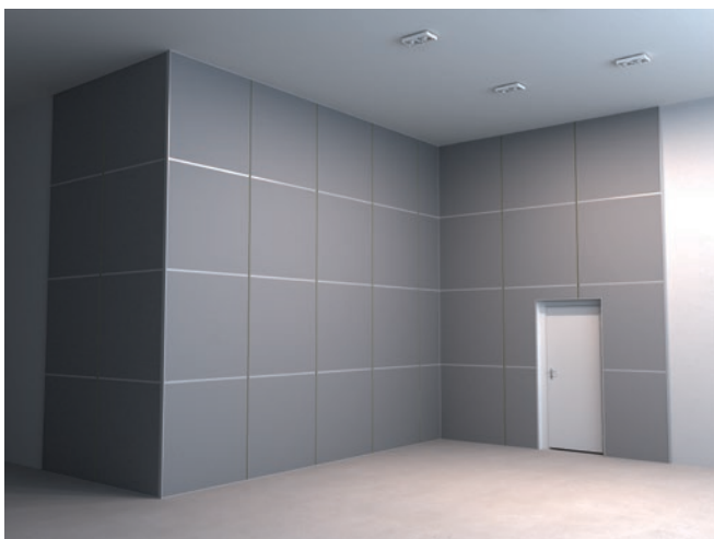
3.11 Installez tous les panneaux intermédiaires restant comme décrit à la page 9, en travaillant du haut vers le bas. Pendant l'installation, recouvrez tous les joints horizontaux par des profils T24 en les clipsant dans les T-pattes de fixation. Une fois toute la surface couverte de panneaux Rockfon VertiQ, la dernière étape est de recouvrir tous les joints verticaux par des longs profils T dans les T-pattes de fixation (voir chapitre suivant).
