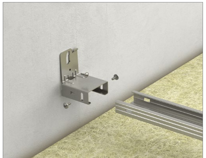
Fixation murale de la fourrure C.
