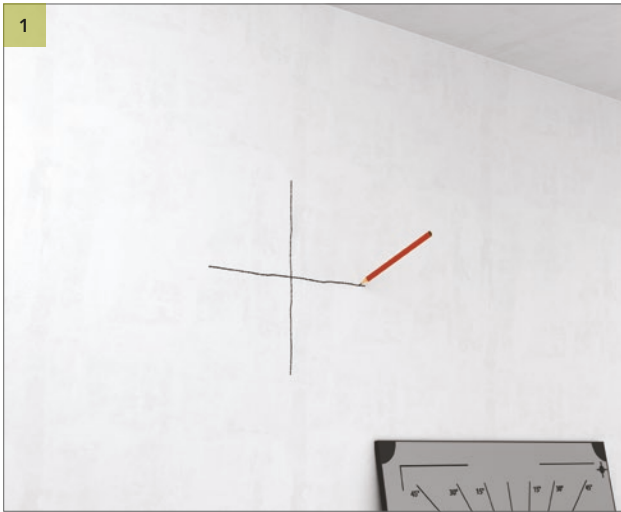
Marquez le mur d'une croix pour indiquer le centre du panneau mural Rockfon Eclipse. Veillez à ce que le trait supérieur de la croix soit de +/- 30 cm.
